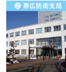
② 帯広防衛支局 帯広地方合同庁舎 (帯広市) 管轄区域/北海道
