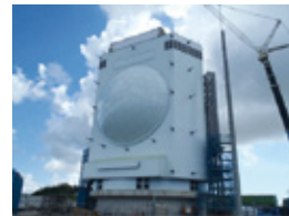
レーダー施設
