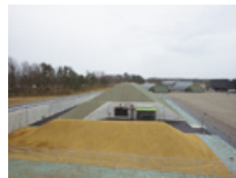
火薬類貯蔵施設
