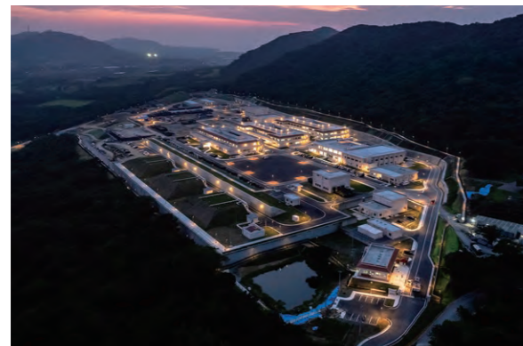
駐屯地の新設／石垣駐屯地
